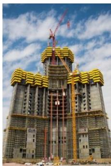
Die WOLFF 355 B Wipper werden mit einem Innenkletterwerk mit dem wachsenden Bauwerk geklettert. Einer der beiden 355 B wird mehrmals umgesetzt und eine finale Hakenhöhe von rund 800 Metern erreichen.
