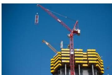
Hohe Arbeitsgeschwindigkeiten von bis zu 185 m/min und ein Hakenweg von 920 Metern zusammen mit beachtlichen Traglasten bei geringer Ausladung überzeugten den Kunden vom WOLFF 355 B.
