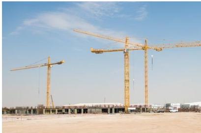
Neben den Wippern ist ein WOLFF-Rudel aus zwölf Laufkatzenkranen Typ WOLFF 7532 vor Ort, die hauptsächlich zur Lastenbewegung am Boden und für den Bau des Podiums am Fuß des Turms eingesetzt werden.
